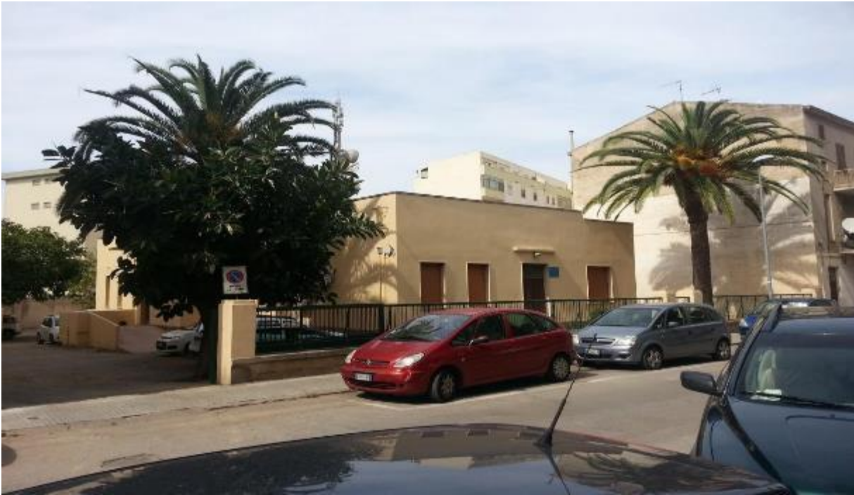
Ingressi alla struttura dell'Ambulatorio di Via Manzoni
